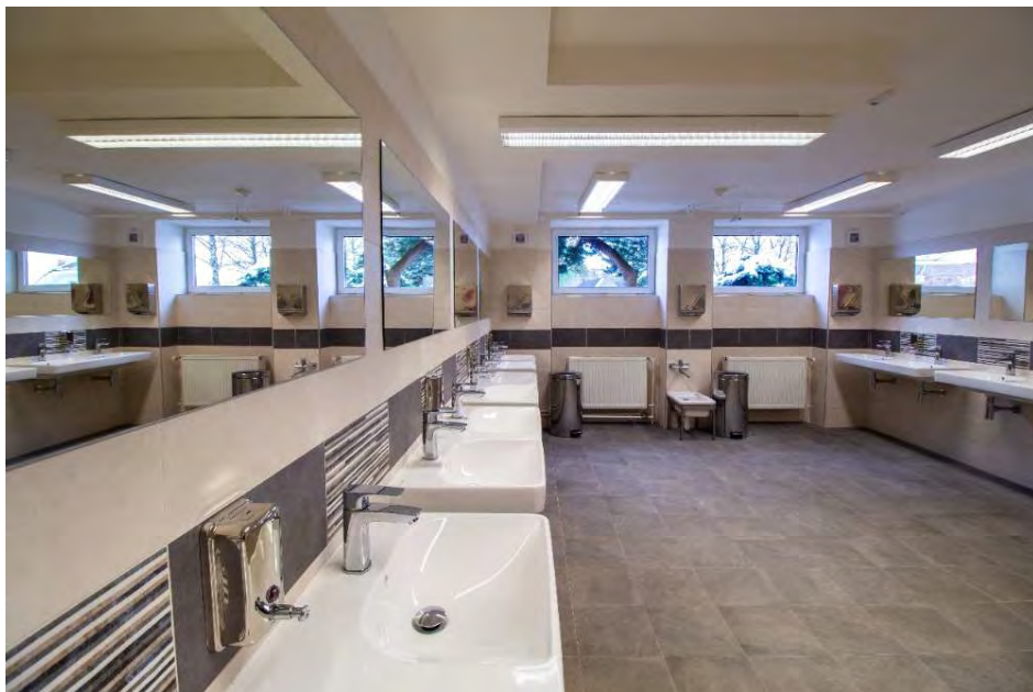
Pohled na nové sociální zařízení. Foto: Václav Brabec
